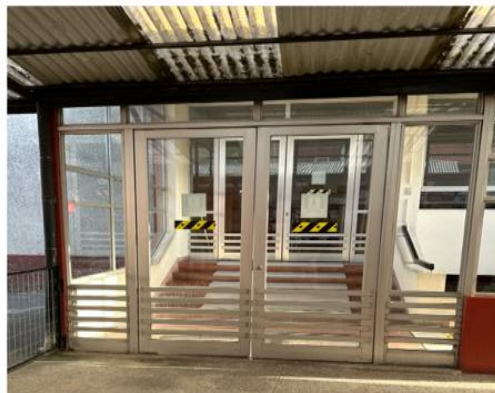
PUERTA CERCANA AL BAÑO
